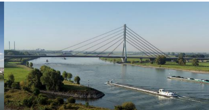
Rheinbrücke Wesel im Zuge der B 86 n
