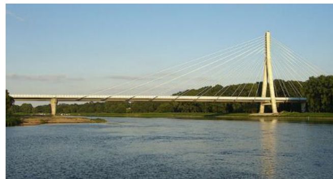
Neue Elbebrücke Schönebeck
