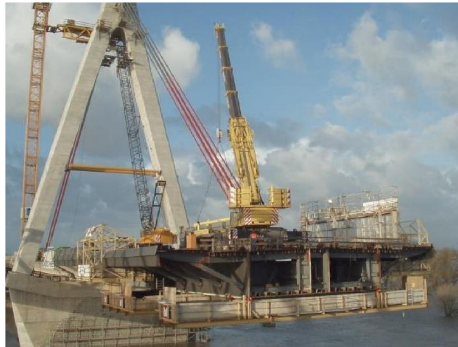
Rheinbrücke Wesel Montage „von oben“ (2005 – 2009)
