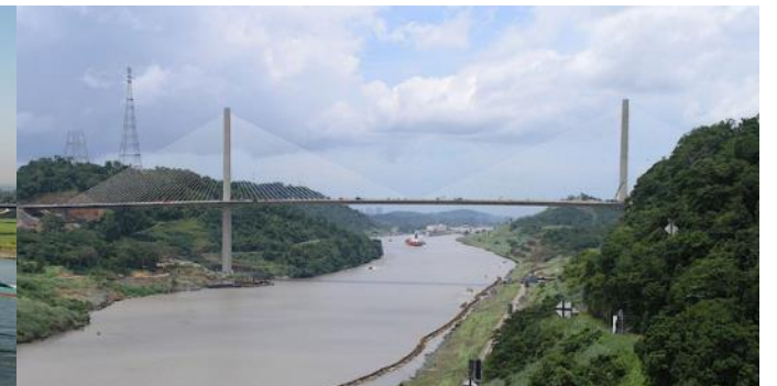
2. Brücke über den Panama-Kanal
