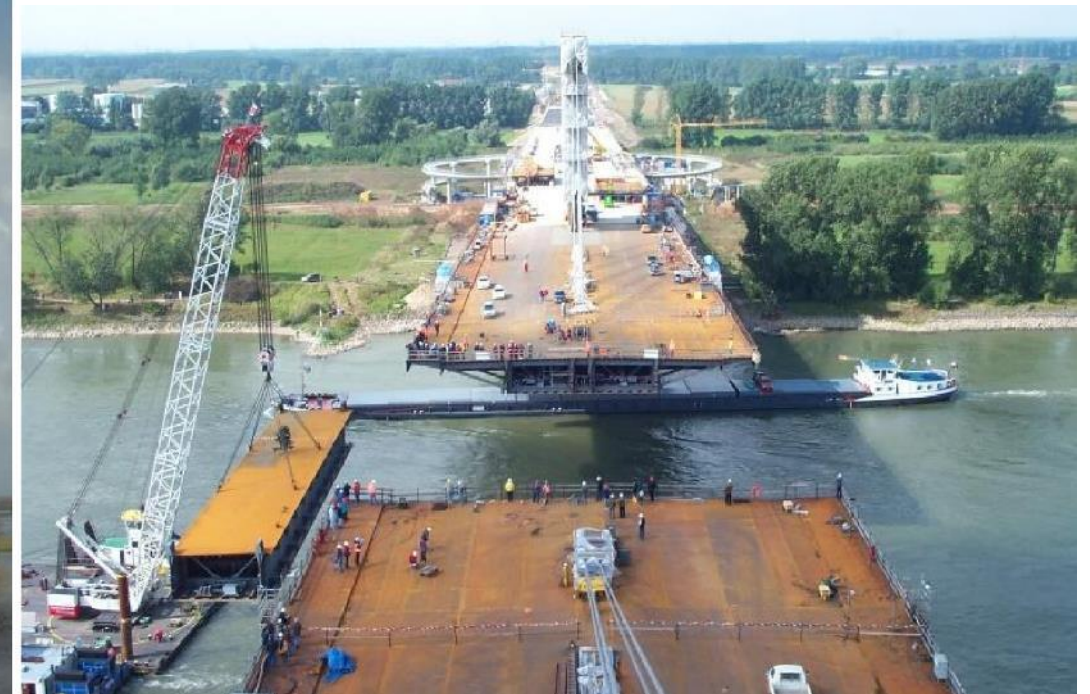
Rheinbrücke Ilverich Einschwimmen der Brückensegmente (1998 – 2002)
